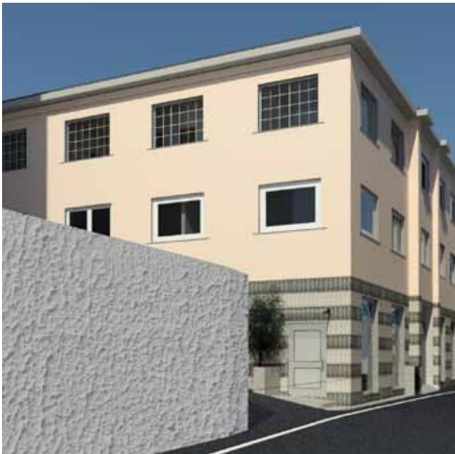
nelle foto: stabilimento in via Arrivabene 36, Genova 1940 - 2025
